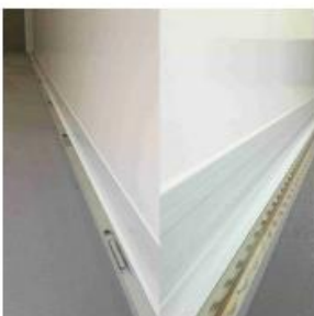
Sjorogen in de vloer
